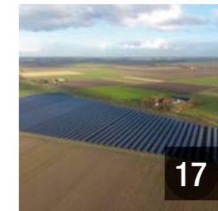
17 光伏地面电站中的中高压一次设备
