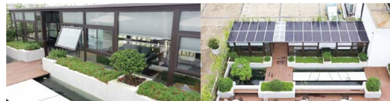
图13: 建设好的阳光房外景
