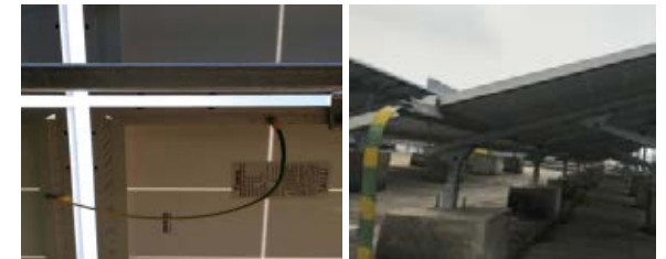
1.5 组件未做好有效接地，系统频繁报绝缘或接地故障
