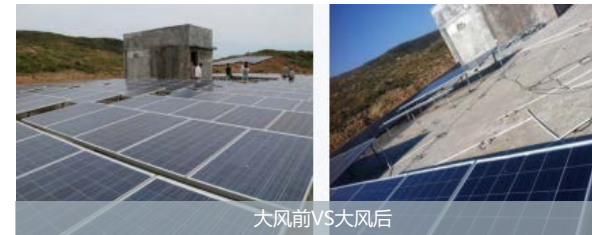
1.2 光伏基础防风等级不够，导致电站一吹就倒
